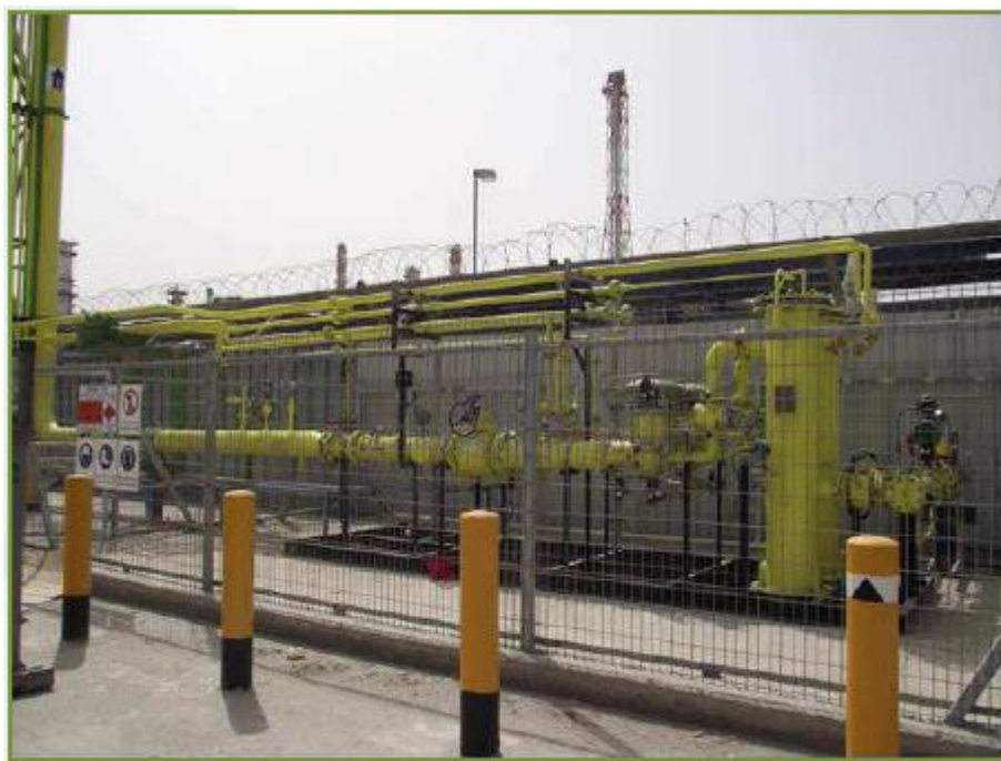
בתמונה – ה-PRMS להפחתת לחץ הגז הטבעי בכניסה לחיפה כימיקלים
